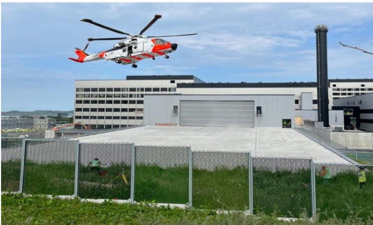
Figur 8-3: Illustrasjon av blastfence ved helikopterbase. Kilde: Garda Sikring
