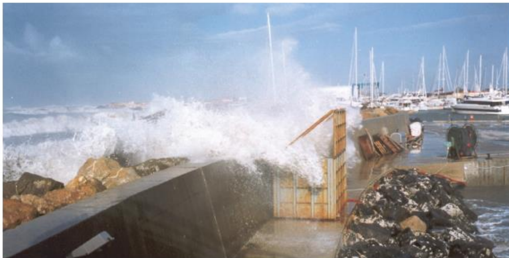
Figur 5: Overskylling ved Ostia, Italia, overskyllingsrater estimert til 0.3-0.6 l/s per m, og maksimum overskyllingsvolum 300-600l, Hs 2.2-2.4 m, fra EurOtop (2016)
