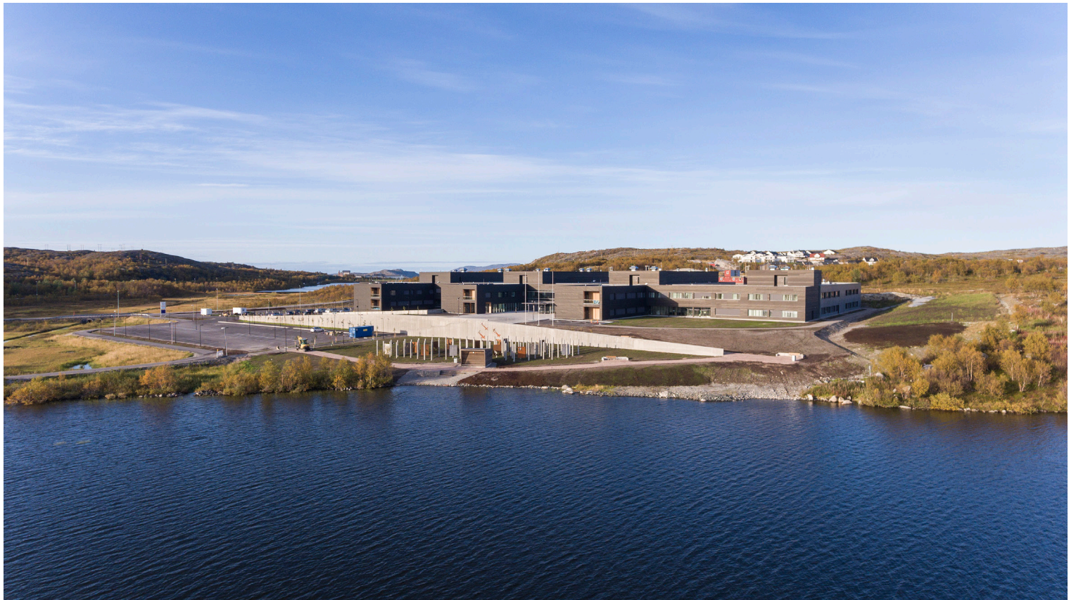
Nye Kirkenes sykehus: sykehuset ligger flott til ved Andrevann.
