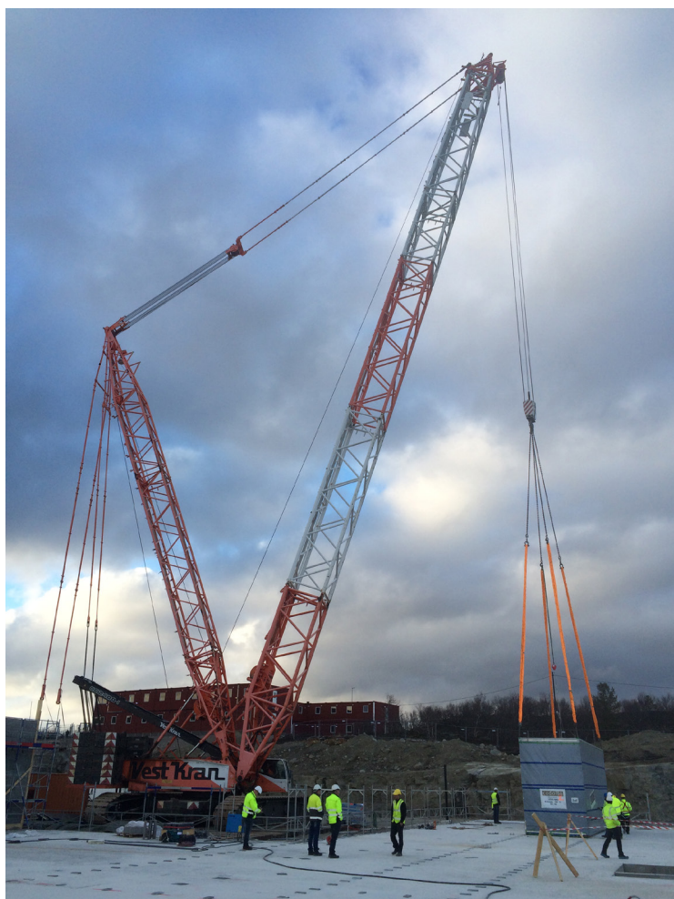
Byggeplass: første seksjon heises på plass mai 2016.
