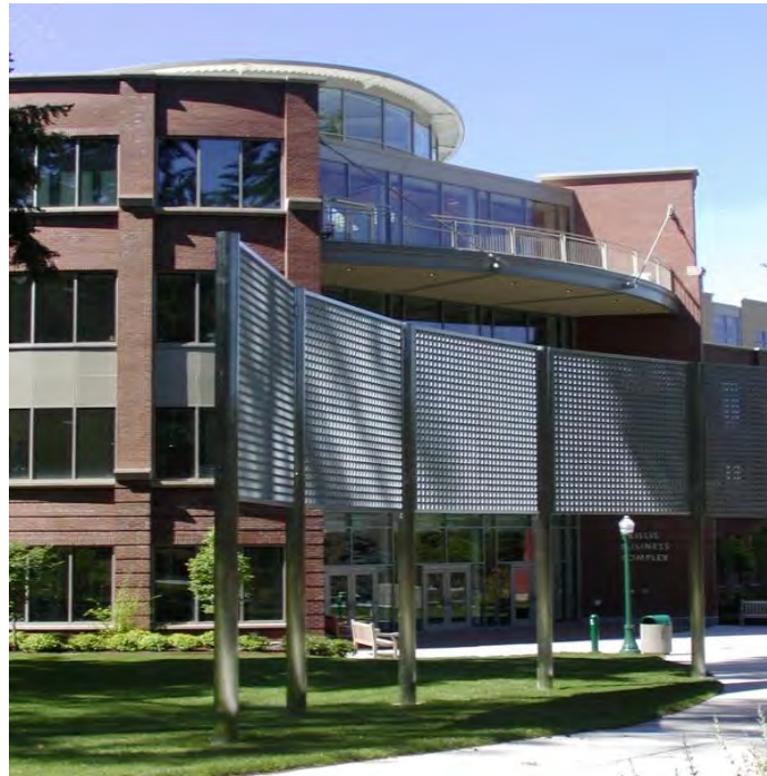
Figur 12 Vindskjerming av inngangsparti.
